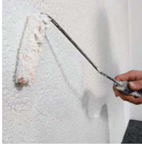
Application of DeKonPeel®.
